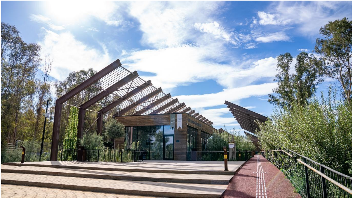
İzmir Tarımı Geliştirme Merkezi- İZTAM girişi dıştan görünümü fotoğraf: Canberk Günay
