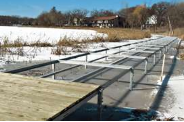
Sulak alan için kullanılan yürüyüş yolunun yapılanması.
